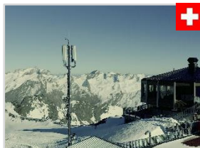
Swiss Towers Fernmeldetürme
